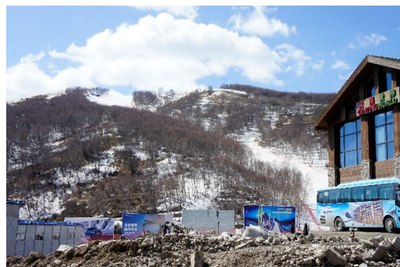
照片 1 张家口市崇礼滑雪场建设工地
